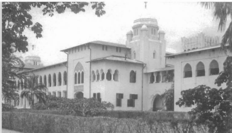
Das Ocean Road Hospital in Dar es Salaam zählt zu den wichtigsten deutschen Kolonialbauten.
